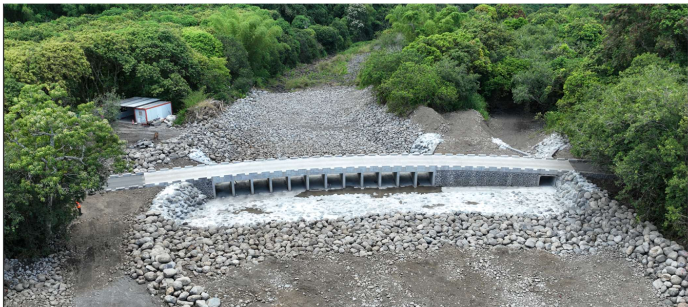
Figure 4 : Réhabilitation du radier d'accès à l'ilet Danclas
